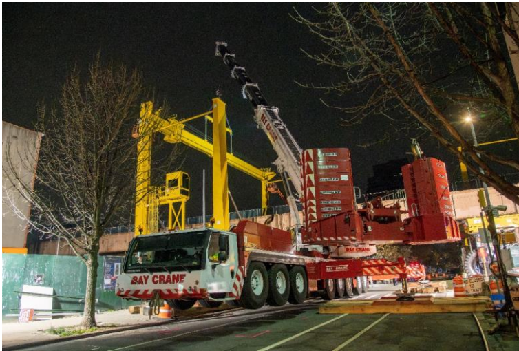
Construcción de pórtico nocturno
