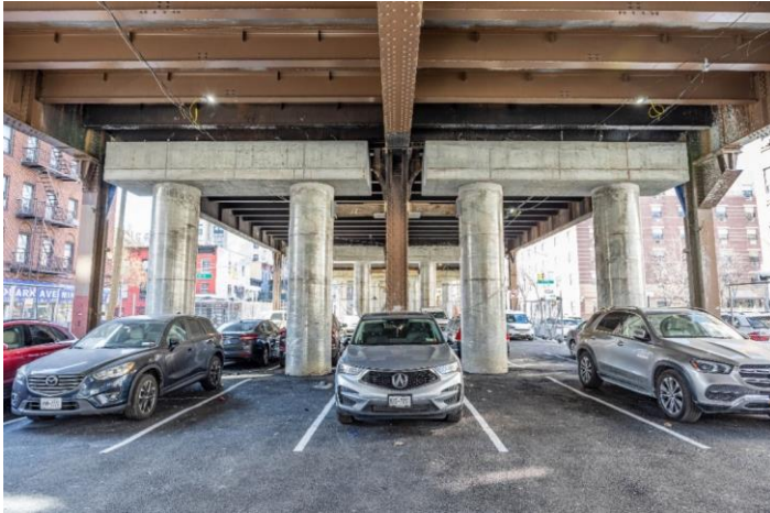
Columnas completadas en el Lote 7 entre las calles E. 117th y E. 118 th
