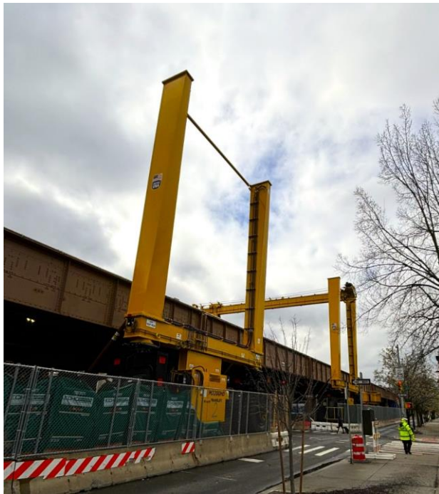
Pórtico con una de las cuatro vigas superiores colocadas
