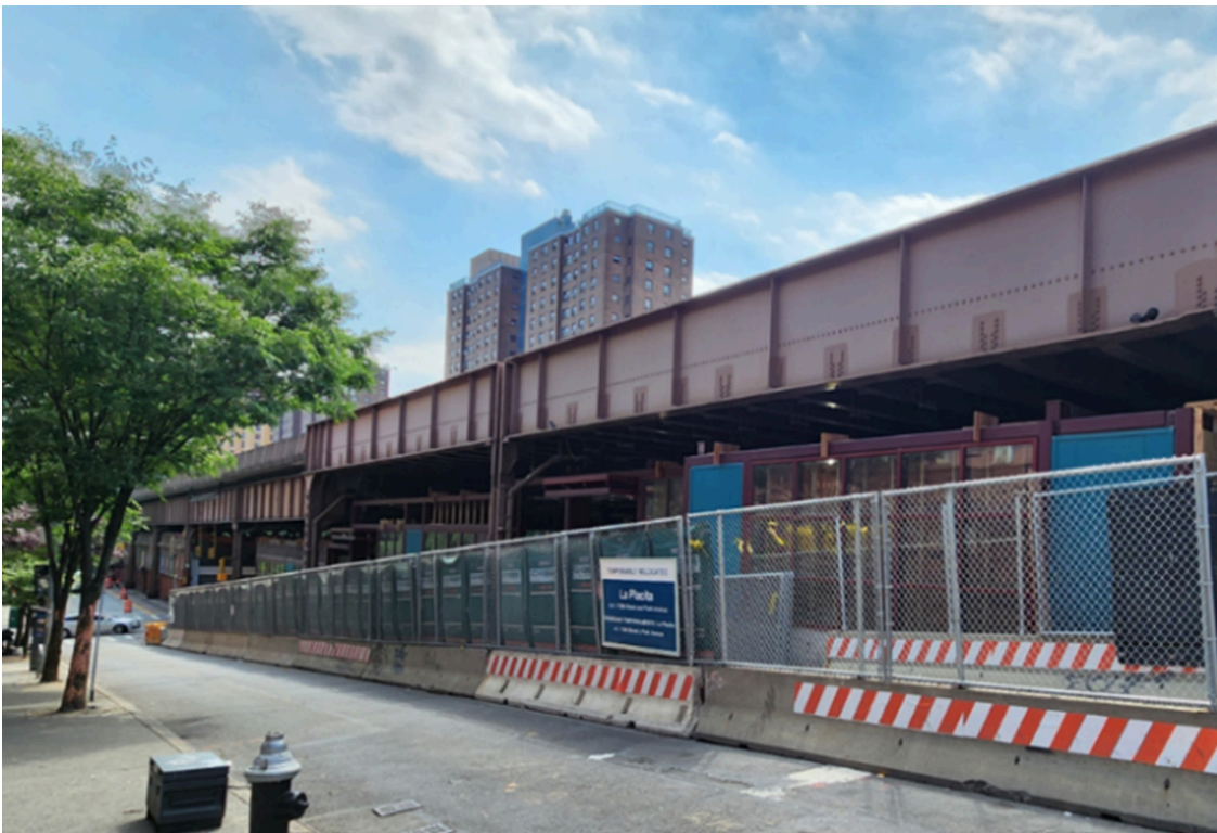
Protección temporal de la zona de trabajo alrededor de La Placita
