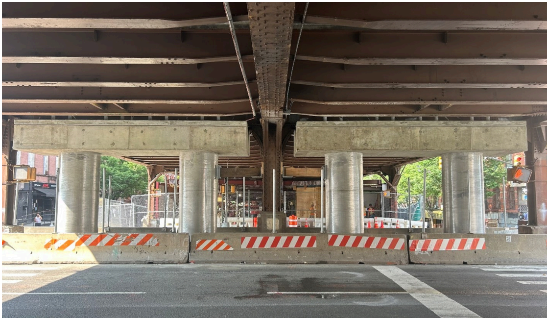
Nuevos cimientos, columnas y tapas de pilares, se completó a East 116th Street
