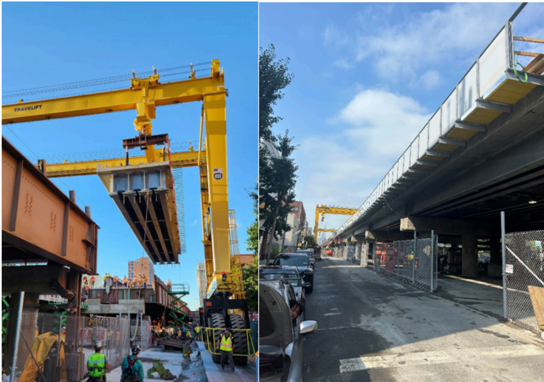
Pórtico colocando la primera unidad de puente prefabricado. Siete segmentos completados (r.)
